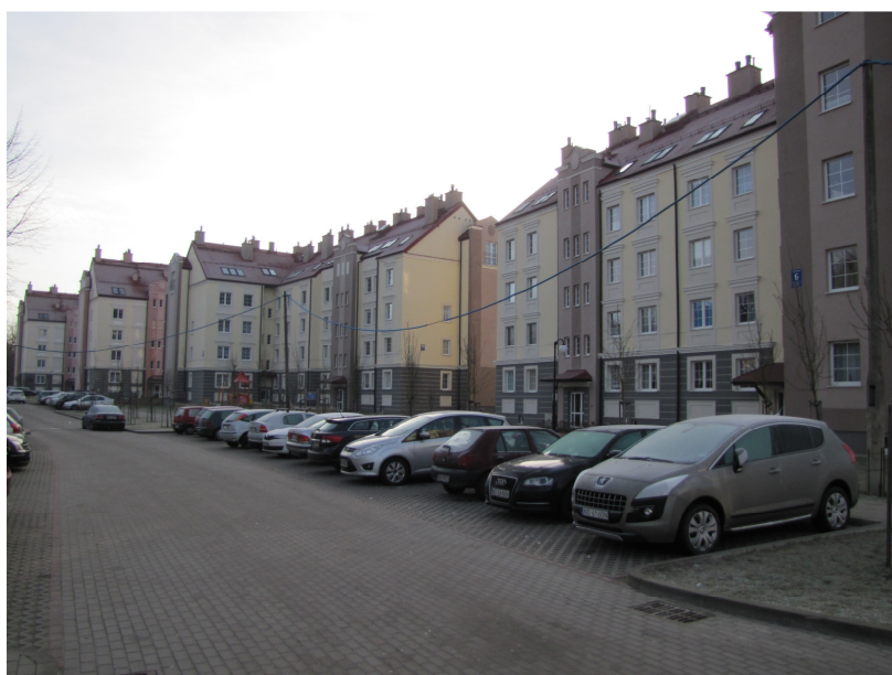
Fig. 2. Housing estate “Estate Przylesie” Photo by Rzasa K. 12.2016
